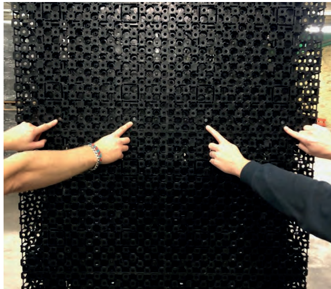
Schritt 11: Schrauben Sie die Seitenplatten an, z.B. 2 Schrauben/Platte. Die Abbildung zeigt 2 Platten = 1 m Breite und 4 Schrauben. Fahren Sie dann auf die gleiche Weise mit der gesamten Breite des Magazins fort.
