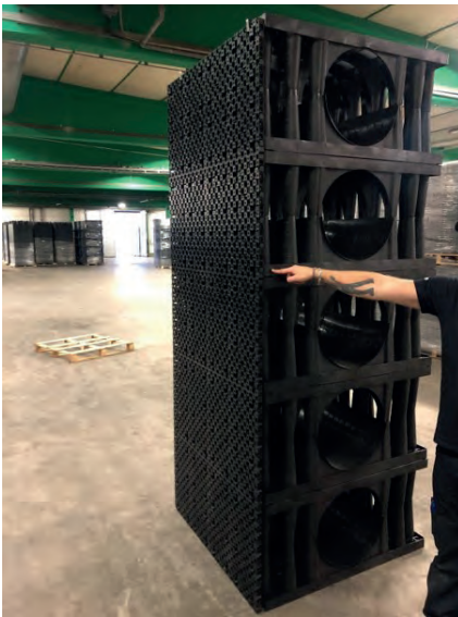
Schritt 10: Die Seitenplatten können auf etwas der Hälfte der Gesamthöhe des "Rahmens" (und eventuell am Boden) angeschraubt werden.
